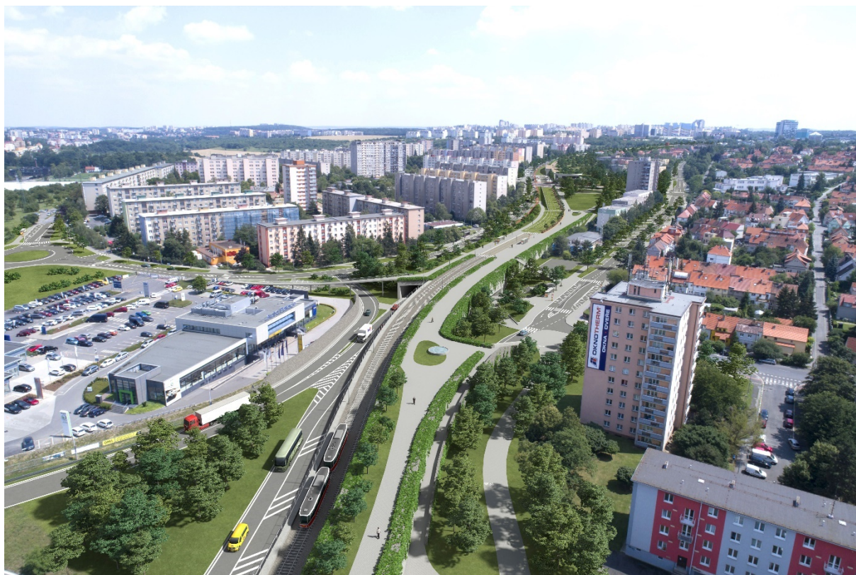
Obrázek 32_pro inspiraci: Návrh těžkého zakrytí Spořilovské spojky - tým autorů PPO + tři architekti, pro TSK 2018, nový 4 ha park na Spořilově spojuje rozdělené území Nového a Starého Spořilova
