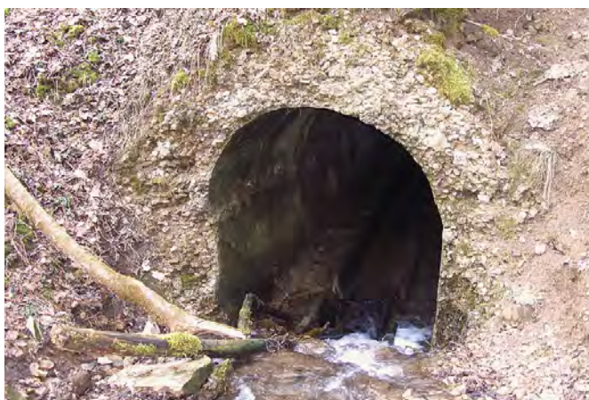
Vodní propustek, Bällbach Německo < https://de.m.wikipedia.org/wiki/Datei:S%C3%B6llbach_Tunnel_Eingang.jpg >
