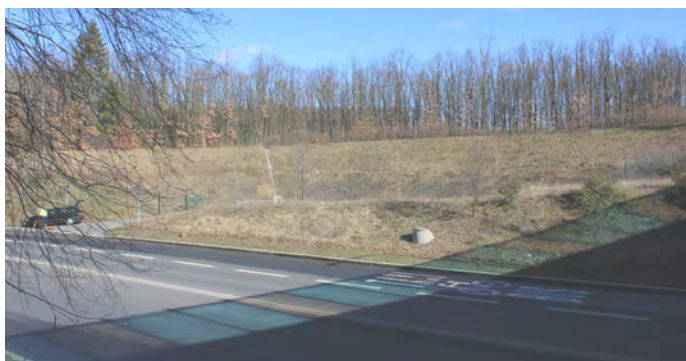
Pohled z ulice Rabakovská na stávající retenční nádrž
