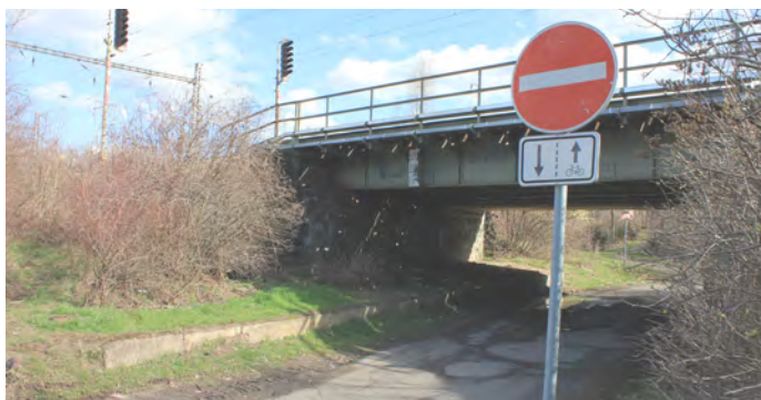
Stávající podchod u Novostrašnické ulice
