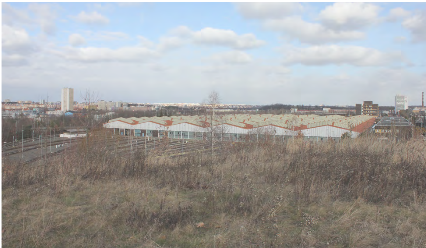
Depo Hostivař - pohled z jihu
