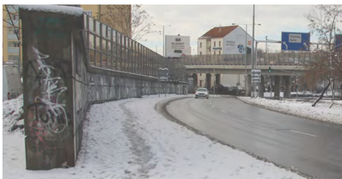
Ulice Čuprova: stávající masivní konstrukce protihlukové stěny
