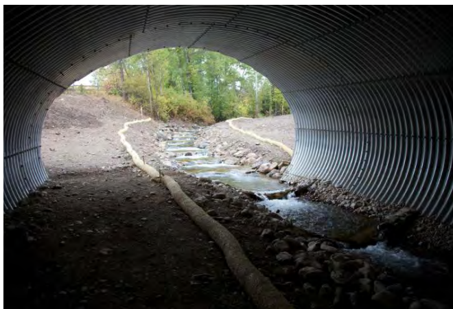
Propustek pro zvířata, USA
