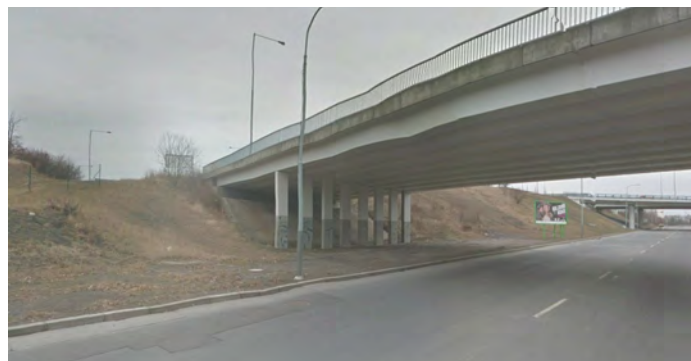
Ulice Rabakovská pod Jižní spojkou - cíleným zavlažováním dešťovou vodou z komunikací lze podpořit přirozenou vegetaci podél ulice Rabakovská a zvýšit tak prostupnost MUK pro zvířata
