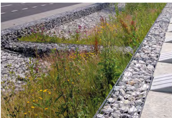
La Havre: dešťová zahrada pro sběr vody ze silnice (FR)
